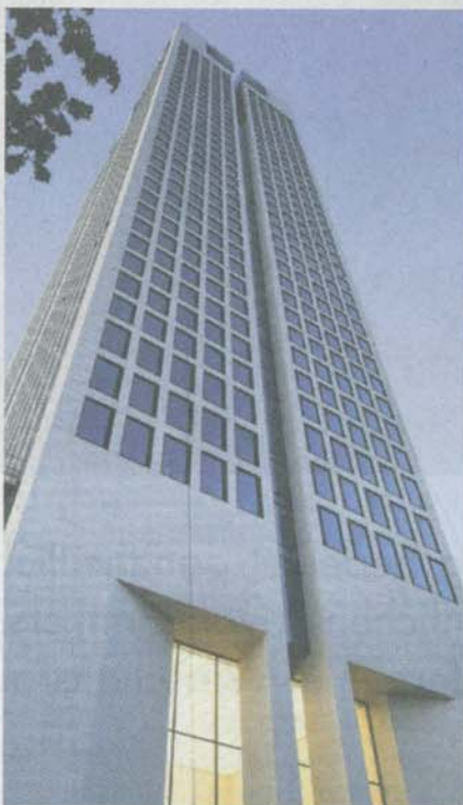
Im neuen «Opernturm» in Frankfurt am Main werden die UBS im Januar 2010 Büros beziehen.
